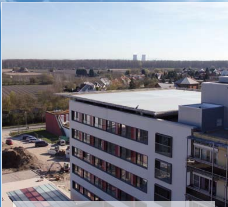
NEU: Hubschrauberlandeplatz auf dem neuen fünfstöckigen Anbau
